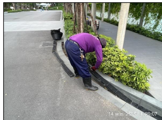
ภาพที่ 43 ตรวจสอบรางระบายน้ำ
