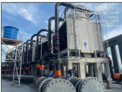
ภาพที่ 22 ระบบปรับอากาศแบบศูนย์รวม (Water Cooled Chiller)
